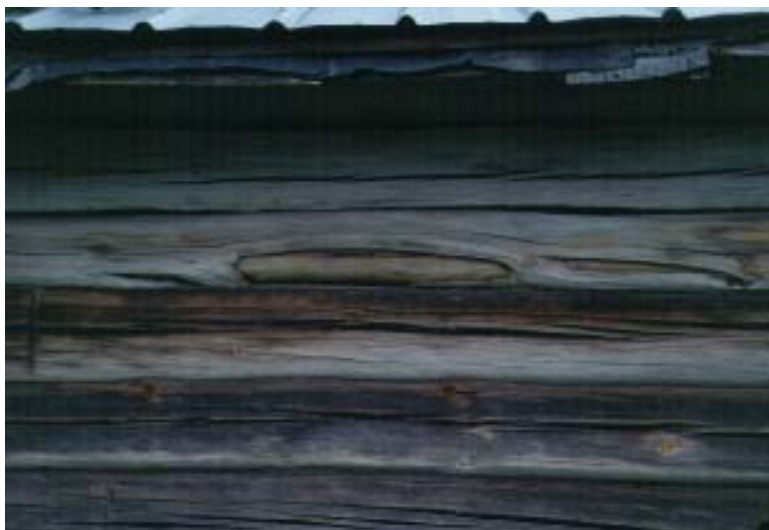
Råsjö 1:25, sommarladugård, detalj av timmervägg
