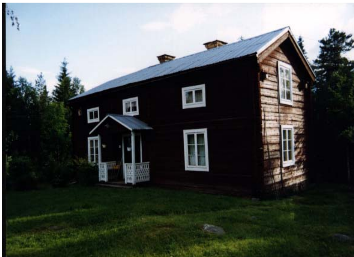
Råsjö 1:16, Gamla mangårdsbyggnaden, från NV
