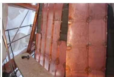
De nya skivorna av kopparplåt
