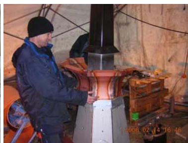
Underdel av utsmyckning måttas in på spiran
