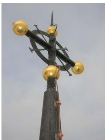
Korset efter åtgärd
