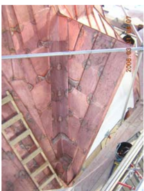
Den nya plåttäckningen
