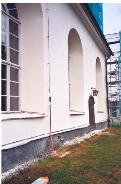
Långhusets nyputsade fasad.
