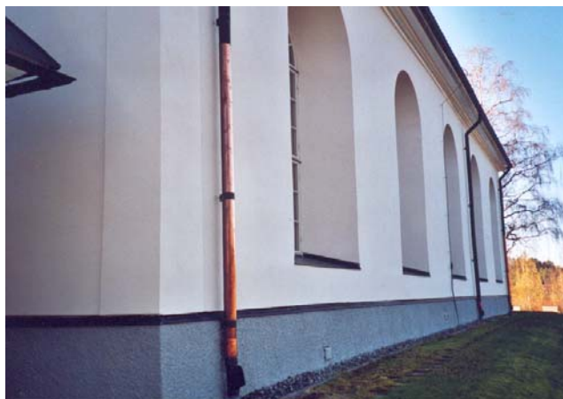
Iskarvat nytt stuprör på baksidan.
