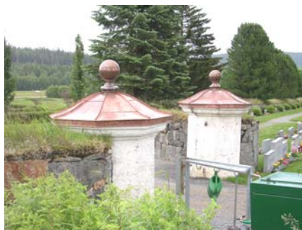
Allén sedd från insidan av muren med silvergranen närmast. Nya kopparhuvar. 2004 07 02.
