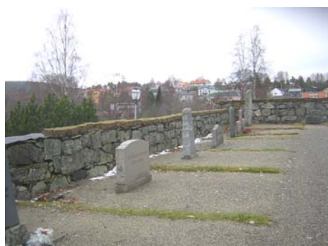
Restaurerad mur mellan gravkapellet och västra muren 2005 10 24.
