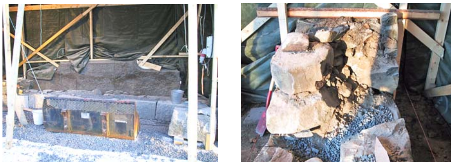
Muren är grundlagd som skalmur bakom graven 2004 11 26. Ursprunglig murdel mot väster (t h).
