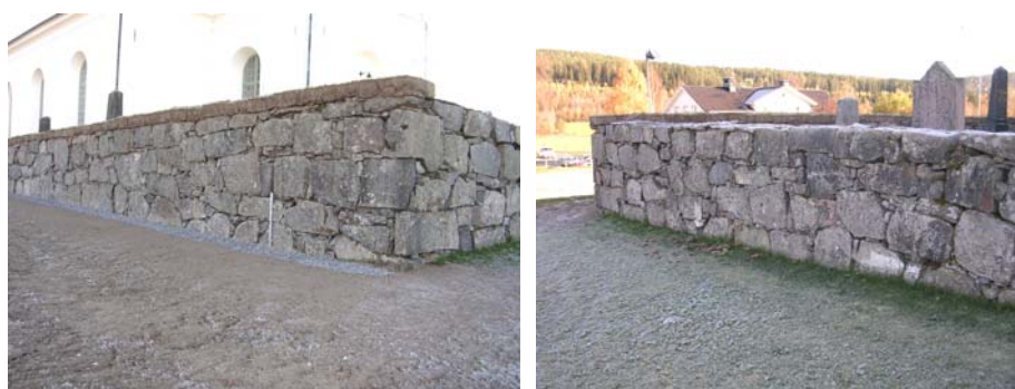
Objekt 4. Norra (NV) delen av den restaurerade muren torvtäckes. Västra (NV) muren. 2004 10 11.
