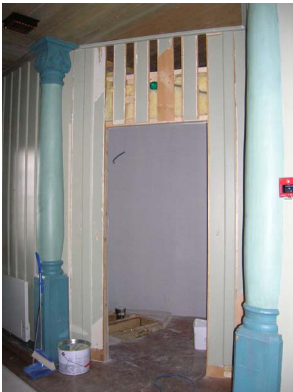
2007 05 11. Breddning av wc-dörren.
