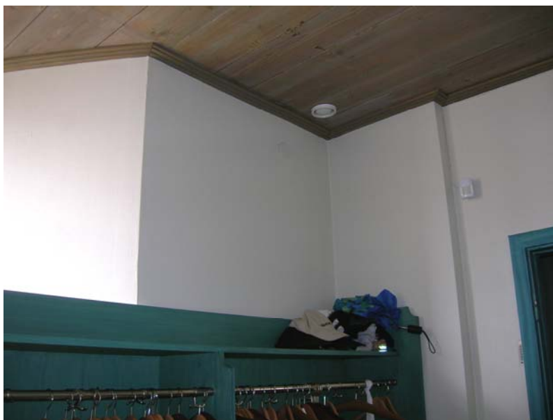
Klädhängaren gick tidigare rakt ut från väggen. Foto före åtgärder 2007 04 23.
