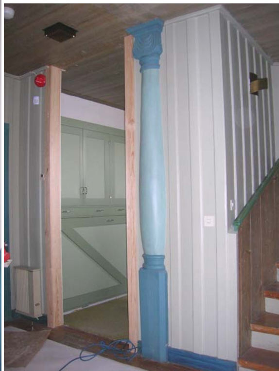
Ingång till kapprum före åtgärder 2007 04 23. Till höger: Rivet väggparti och breddad öppning mot kapprum 2007 05 11.
