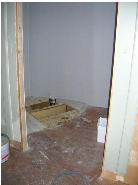
Wc under ombyggnad. 2007 05 11.
