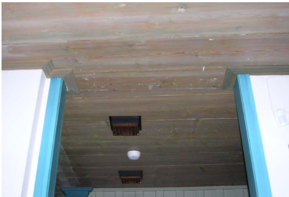
2007 12 04. Inifrån kapprummet med ny taklist lik befintlig kring ny väggöppning.
