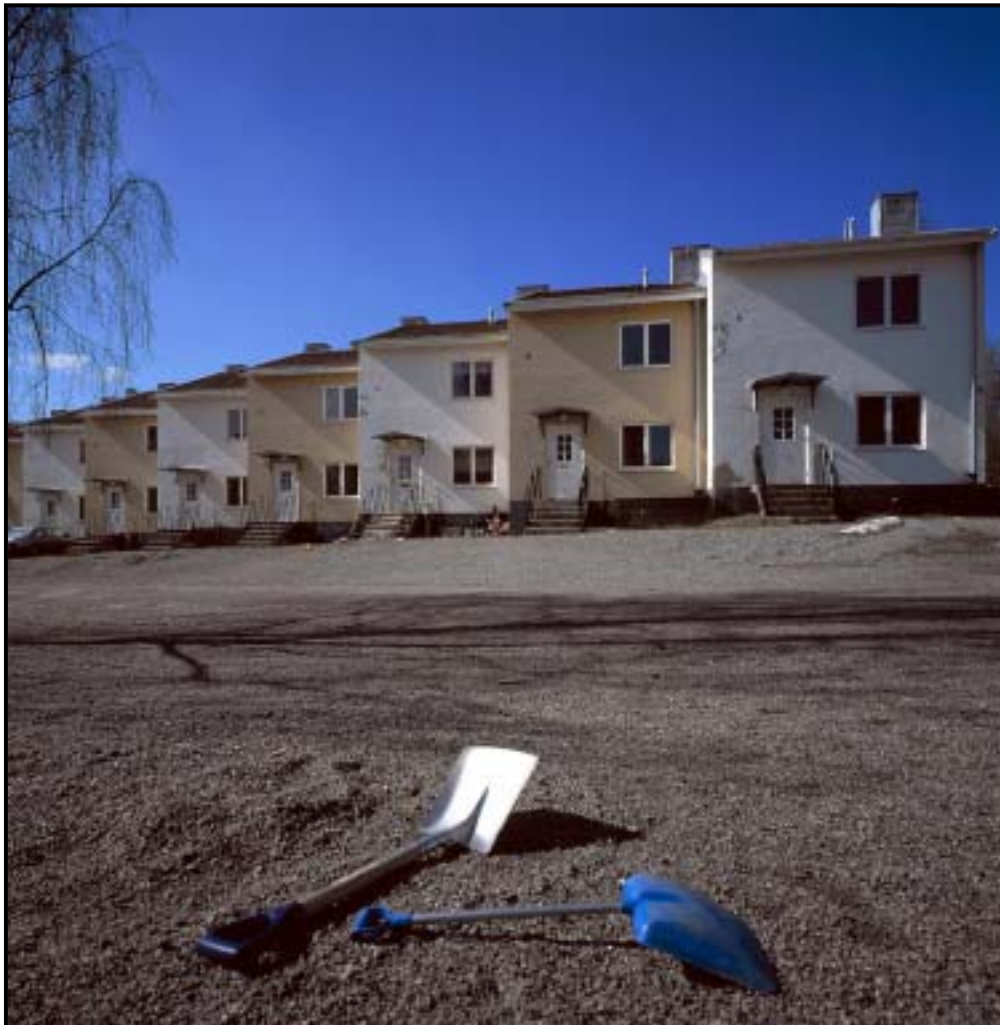
Bild 16; Radhus B längs med Solnäsvägen.
