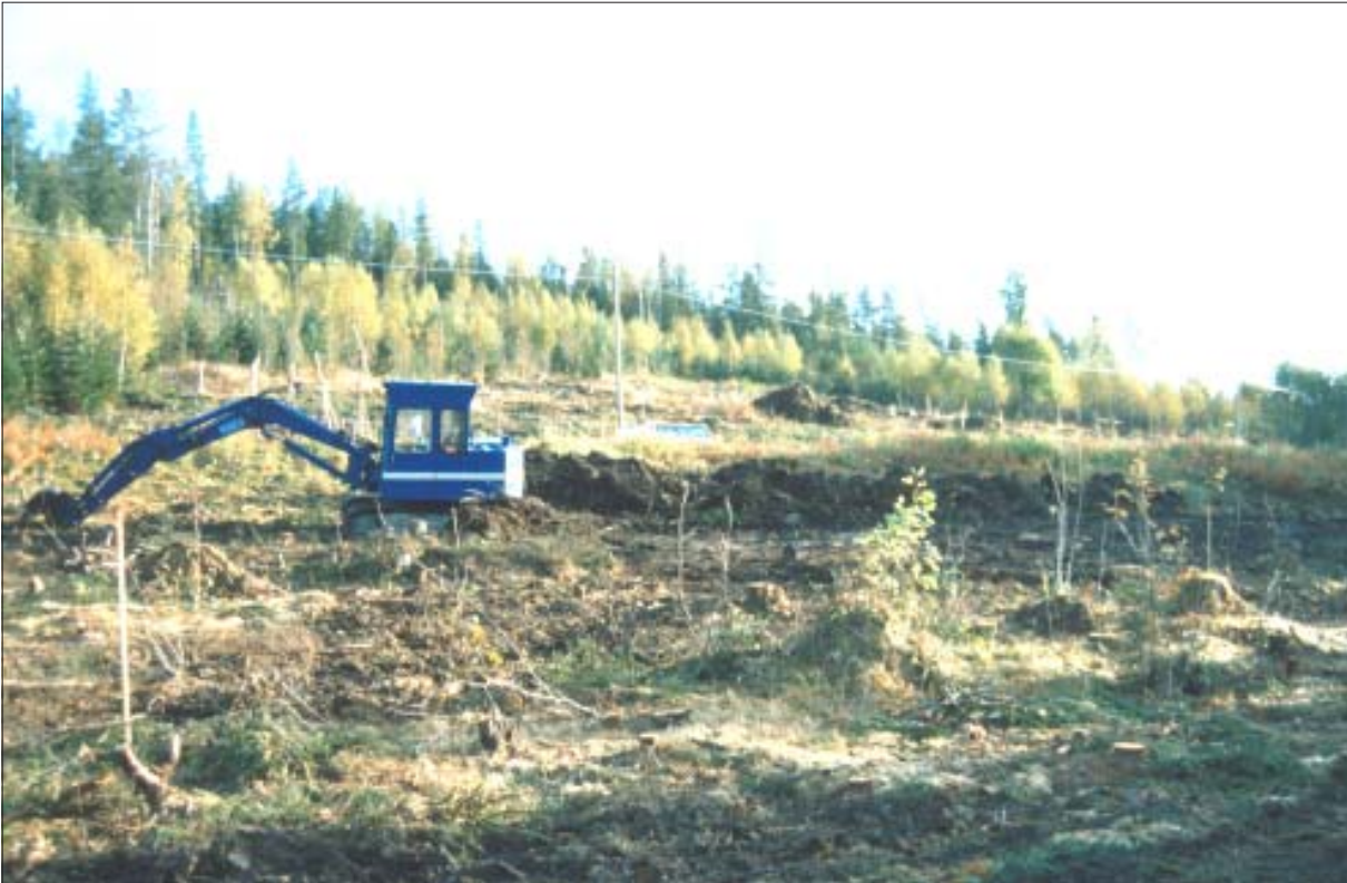
Fig. 5. Grävmaskinen avlägsnar växttäcket inom Yta B. Vy över den avverkade järnvägskorridoren och undersökningsområdet. I bildens mitt anar man Kornsjövägen genom ett uppstickande biltak. Foto från sydväst.
