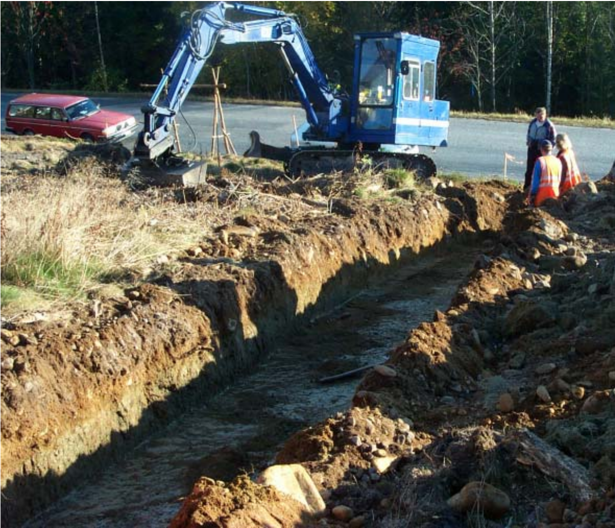
Fig. 17. Ett närmare 22 m långt och 1 m djupt schakt grävdes genom yta A.
