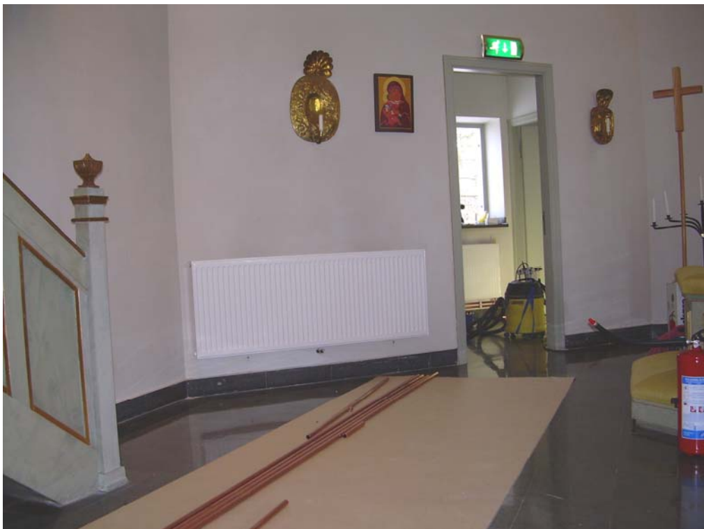
2008-02-28. Installation av vattenburen radiator vid korets norra sida.
