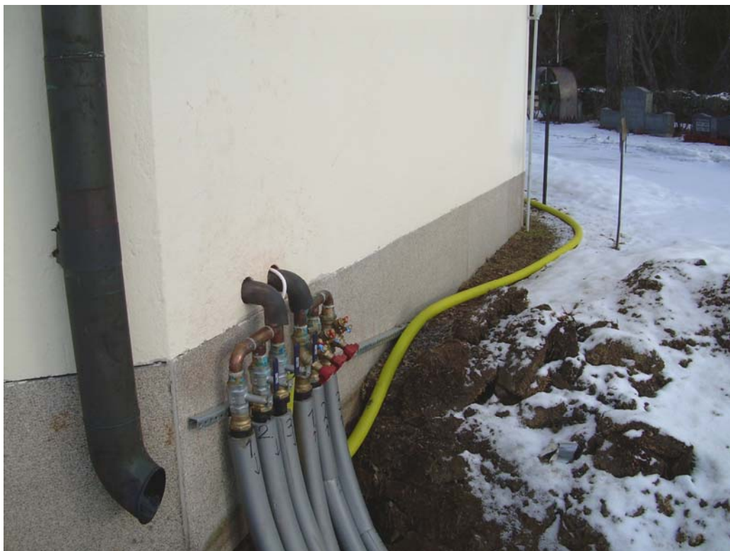
2008-02-28. Anslutning till bergvärmens och rördragning i sydost.
