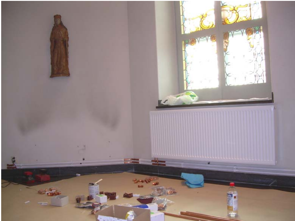
2008-02-28. Ny vattenburen rörledning från förråd till kor före inmålning av rör.
