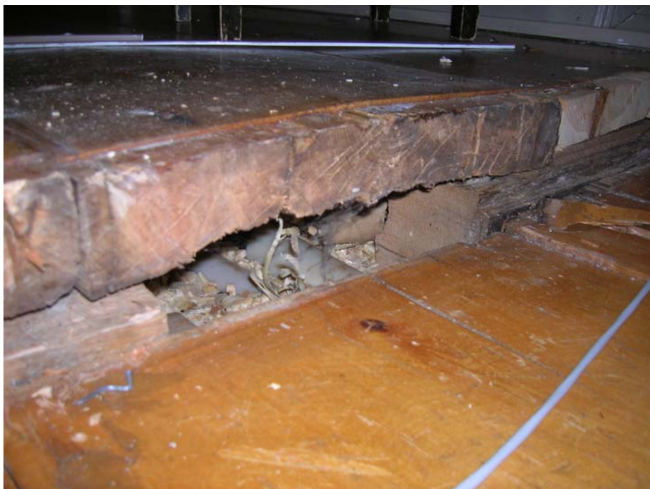
2007-05-14. Listen mellan korgolv och kyrkgolv har demonterats och bjälklaget är synligt.
