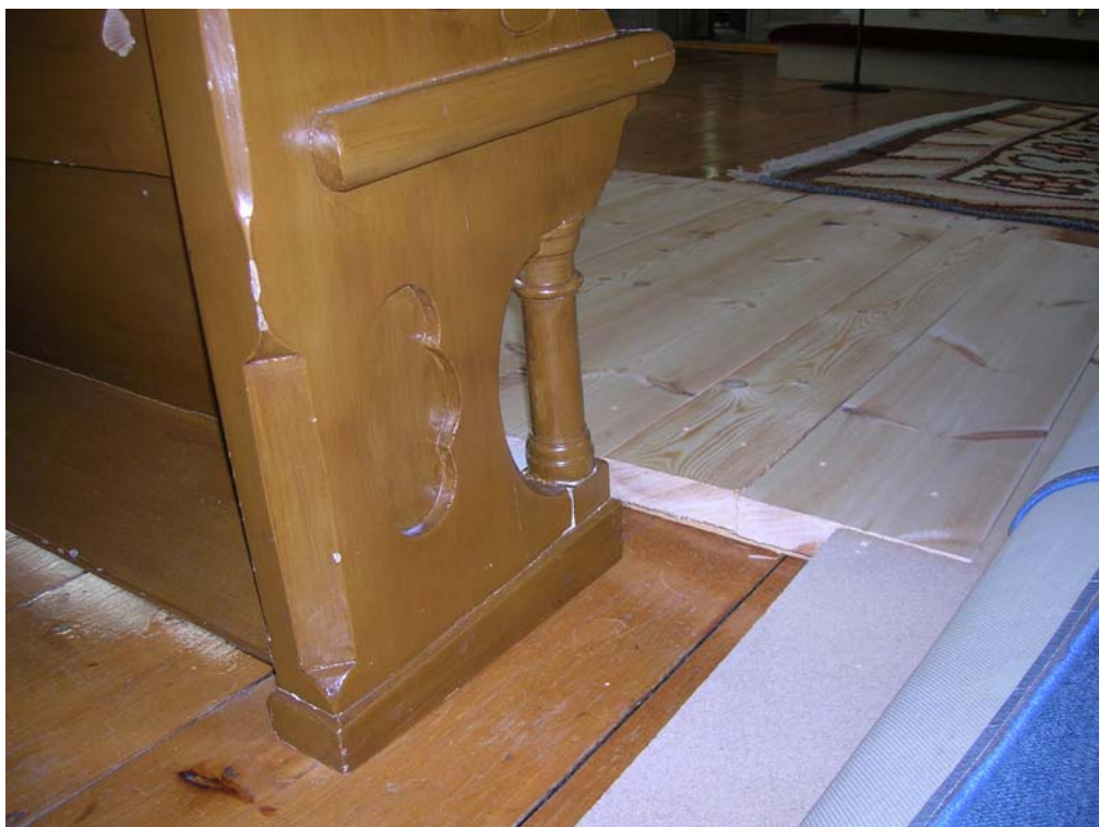
2007-06-14. Bänkskärmarna ännu ej återmonterade, ej heller listen mellan de olika höga golvytorna.
