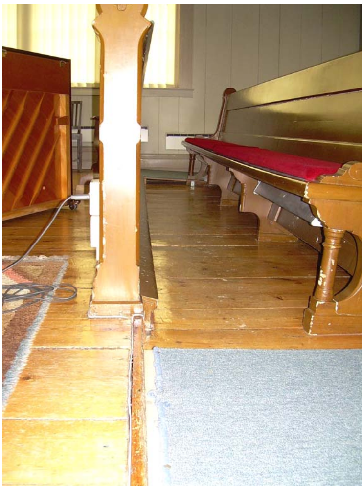
2007-05-03. Främsta bänken före ombyggnaden. Foto mot söder.
